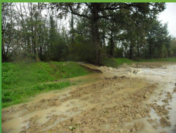
Brèche dans un merlon sur le Crieu (source SYMAR VA)
