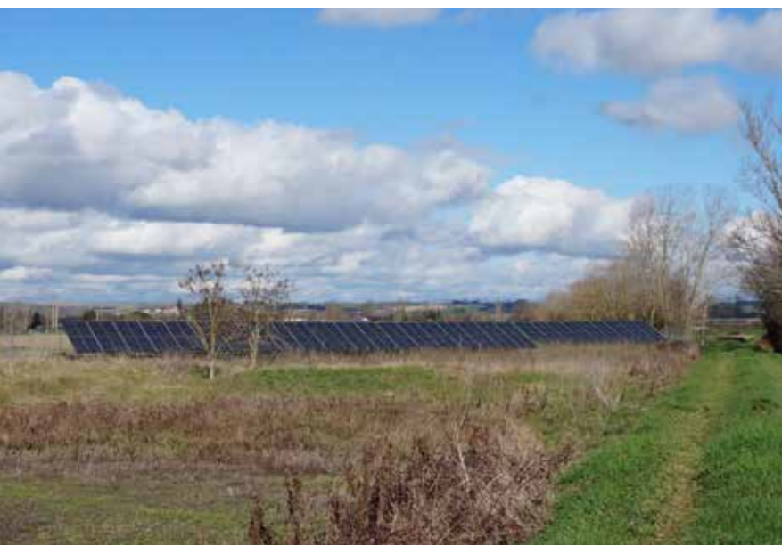
▲ Chemin communal longeant le parc solaire à Saint-Quirc. © CAUE de l'Ariège
