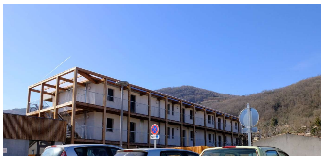
Opération cœur de bourg à Ferrières-sur-Ariège. Source : AUAT
