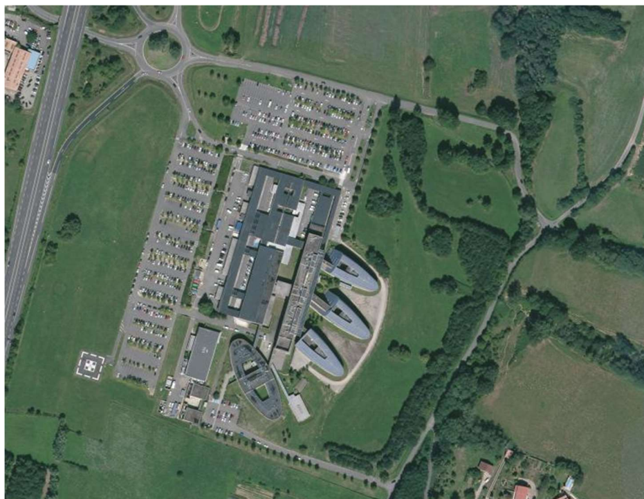
Le CHIVA, équipement structurant sur la commune de Saint Jean de Verges
