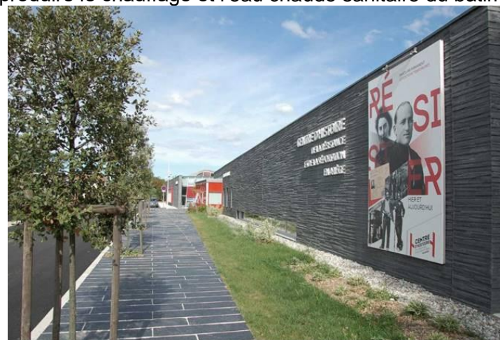
Figure 12 : Pôle culturel de l'agglomération à Varilhes
