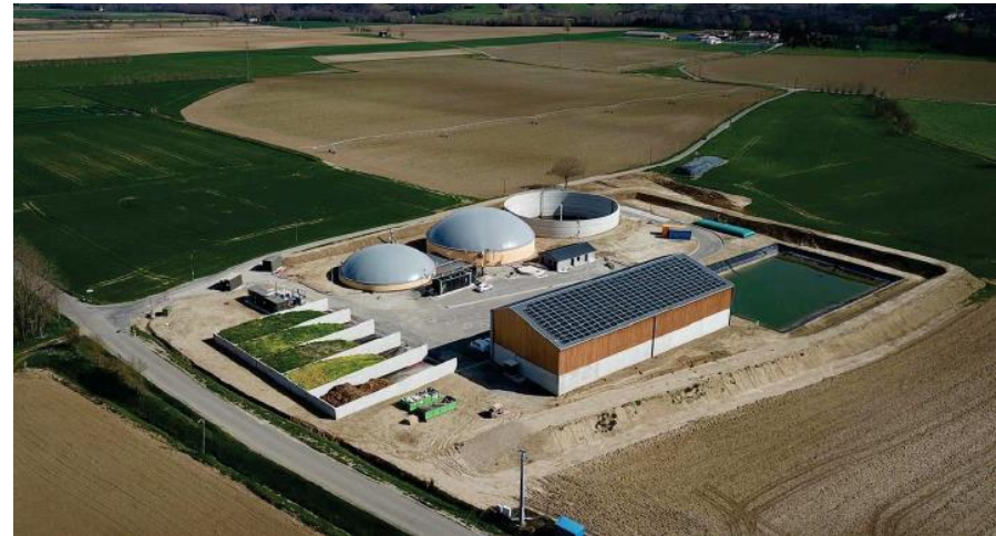
Figure 12 : Usine de méthanisation Ariège Biométhane à Ludiès
