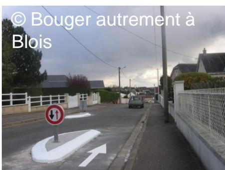
En cas d'implantation d'écluses ou d'autres dispositifs de rétrécissement de la chaussée, prévoir de conserver un « bypass » vélo. Cependant, ces aménagements s'ils sont trop étroits (<1,50m) sont difficilement nettoyables et accumulent les graviers... Ces by-pass doivent être courts pour ne pas créer un effet tunnel. Les éventuels plots utilisés pour les écluses doivent être déformables au choc.
