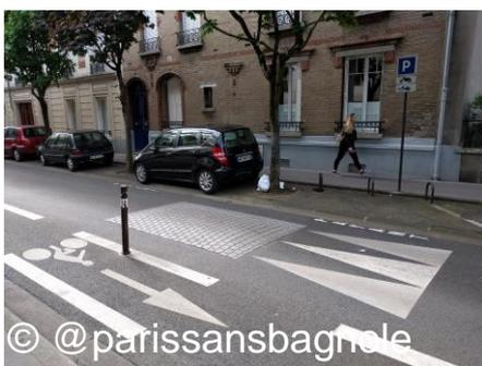
Les dos d'ânes, coussins et plateaux sont pénalisants pour les vélos, notamment avec remorques. Ils doivent respecter le coefficient de rugosité préconisé par le Cerema (0,45) pour éviter les glissades en cas de pluie. L'utilisation est possible à défaut d'autres dispositifs de ralentissement. Les plateaux sont préférables aux coussins berlinois (cf page suivante). Les dos d'âne sont à éviter.
