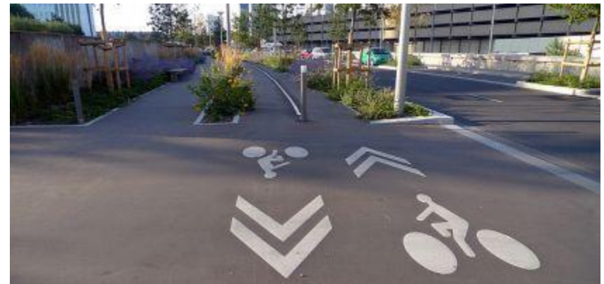
Marquage au sol pour montrer la présence des cyclistes
